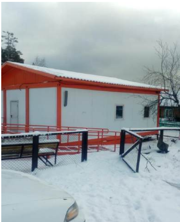
10) Фельдшерско акушерский пункт, по адресу: Усть-Илимский район, поселок Бадарминск, ул. Почтовая, 5
