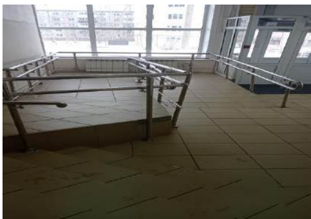
пандус и перила внутри здания.
